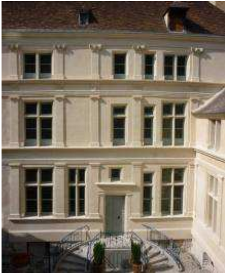
Vue de la façade restaurée
