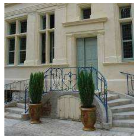
Vue du perron après restauration
